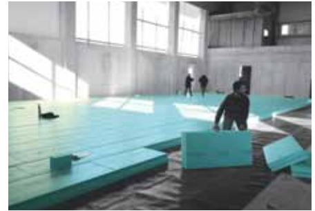
Posa in opera di pannelli termoisolanti FIBRANxps 500-L sotto la fondazione a platea
