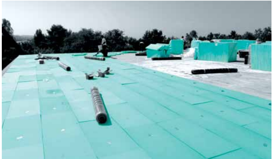
Aumento dell'inclinazione e risanamento dell'isolamento termico di un tetto piano con pannelli FIBRANxps INCLINE
