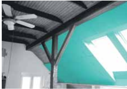
Realizzazione di isolamento termico dall'interno con pannelli FIBRANxps ETICS , che verrà intonacato o verniciato
