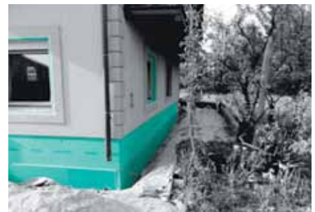
Isolamento termico dei ponti termici delle spallette e della zoccolatura con pannelli FIBRANxps ETICS
