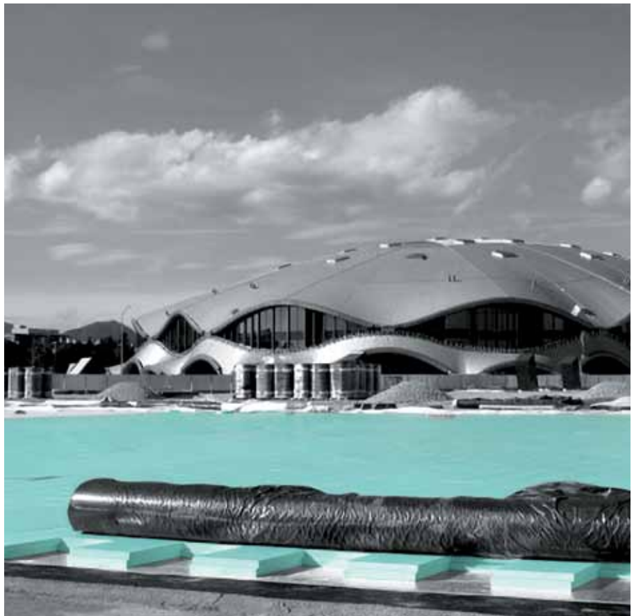
Isolamento termico delle sezioni di un tetto piano con pannelli FIBRANxps di diversi valori di resistenza a compressione
