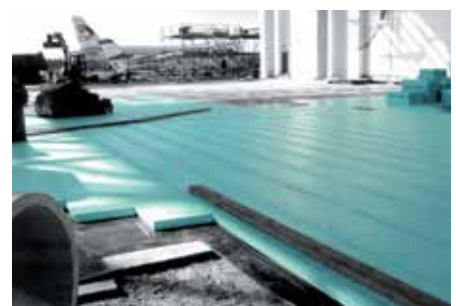
Protezione antigelo delle pavimentazioni degli hangar aeroportuali con FIBRANxps 700-L
