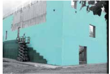
Pannelli FIBRANxps MAESTRO in intercapedine mentre viene eseguito il paramento esterno di facciata con cemento a vista
