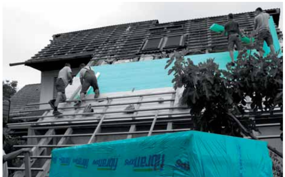
Trasformazione di un sottotetto in una mansarda abitabile realizzata con la membrana riflettente FIBRANskin VENT SILVER ed i pannelli termoisolanti FIBRANxps MAESTRO .
