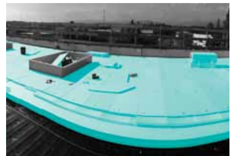
Realizzazione dell'inclinazione con pannelli FIBRANxps INCLINE e fissaggio di pannelli FIBRANxps su un tetto privo di protezione pesante
