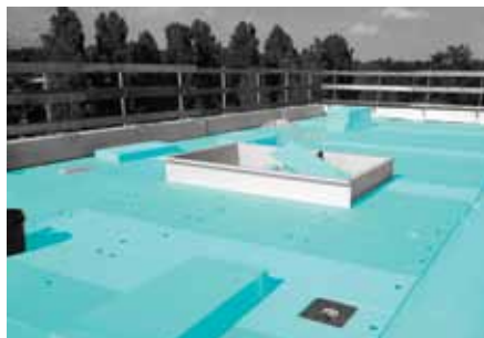
Realizzazione dell'inclinazione con pannelli FIBRANxps INCLINE e fissaggio di pannelli FIBRANxps su un tetto privo di protezione pesante
