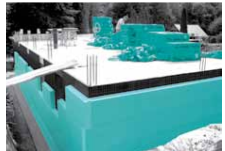
Pannelli isolanti FIBRANxps 300-L (resistenti meccanicamente e impermeabili) hanno funzione di protezione meccanica dello strato impermeabilizzante e d'isolamento termico della struttura interrata, anche nel caso di un livello alto della falda idrica
