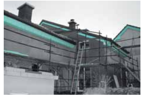
Sporti di gronda realizzati con pannelli FIBRANxps ETICS . Lo spessore dipende dalla campata.
